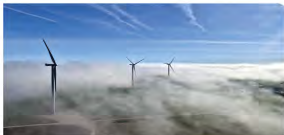
Parc éolien du Langrois, extension du parc de Langres Sud, mis en service en 2024.
